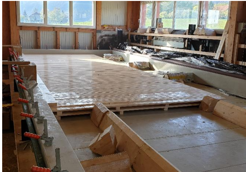
image 2, mise en plis des planches encollées, JPF-Ducret SA Orges (VD) (Fritschi 2019)
