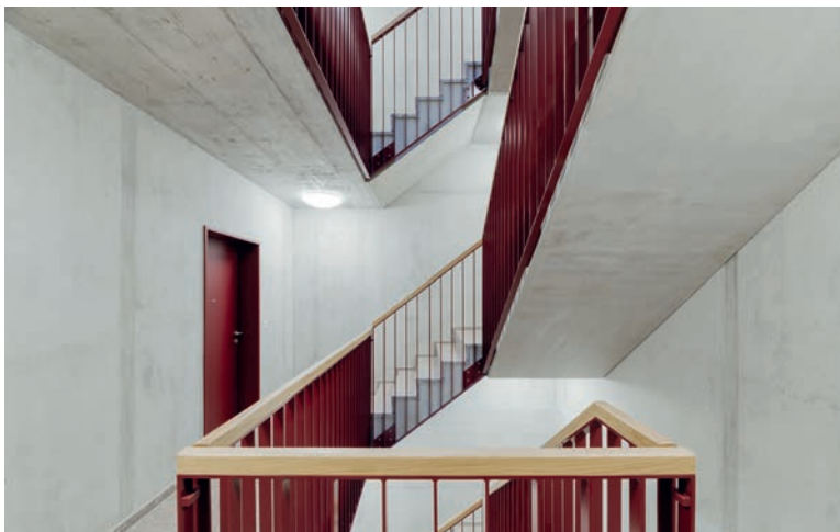
Die Treppenkerne aus Sichtbeton steifen das Gebäude aus.
