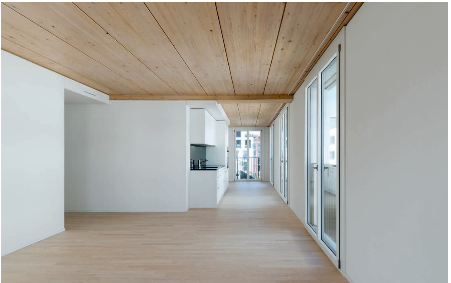
Aussen verkleidet ein Aluminiumblech den Holzbau, in den Wohnungen zeigt er sich.
