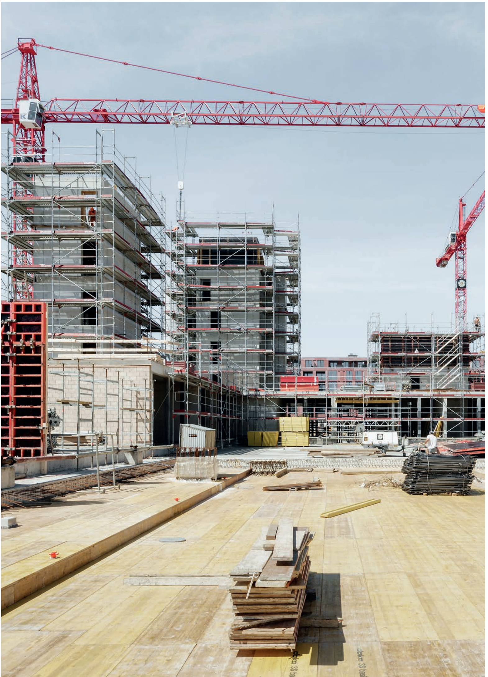
Vorfabrizierter Wohnungsbau: Nach dem Betonieren des Erdgeschosses und der Treppenhäuser dauerte die Montage der Holzbauelemente pro Etappe nur rund einen Monat.
