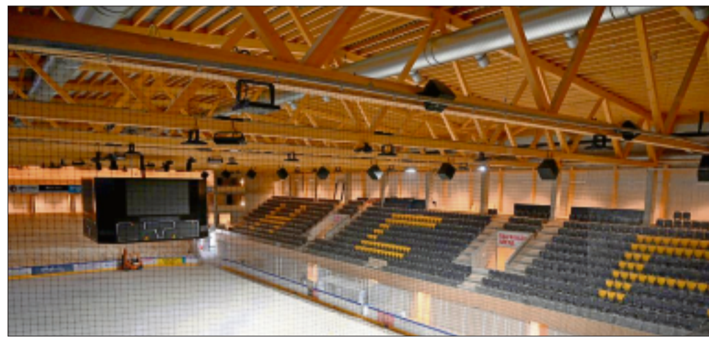
La charpente de la patinoire, que le grand public se languit d'apprécier, est composée d'un mélange d'épicéa et de sapin, ainsi que de frêne. Le bardage extérieur est quant à lui réalisé en sapin. ARCHIVES ROBERT SIEGENTHALER
