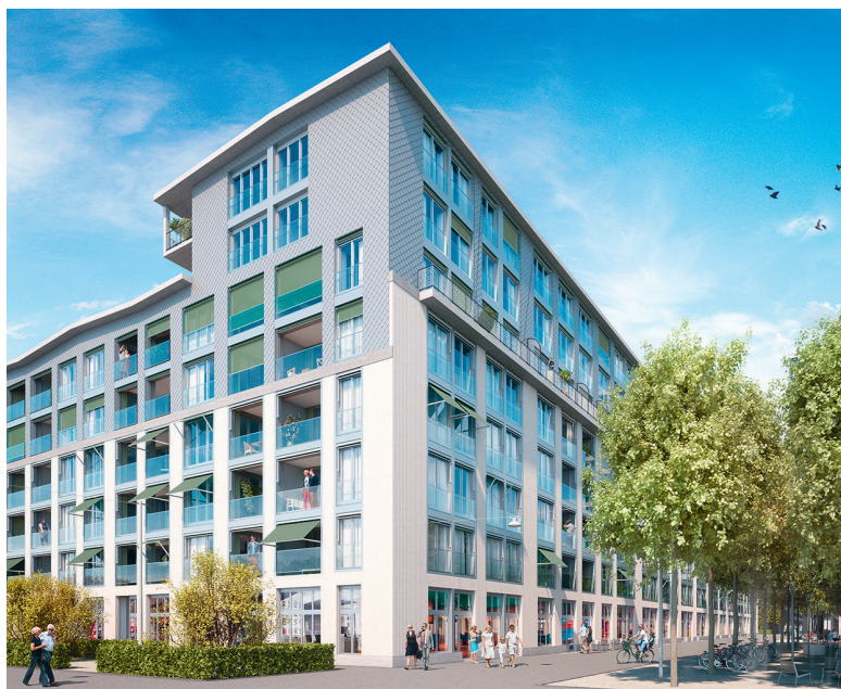
Grösstes Schweizer Holzbauquartier: Die Grundsteinlegung für das Haus Krokodil in der Winterthurer Lokstadt erfolgte im Juli.
