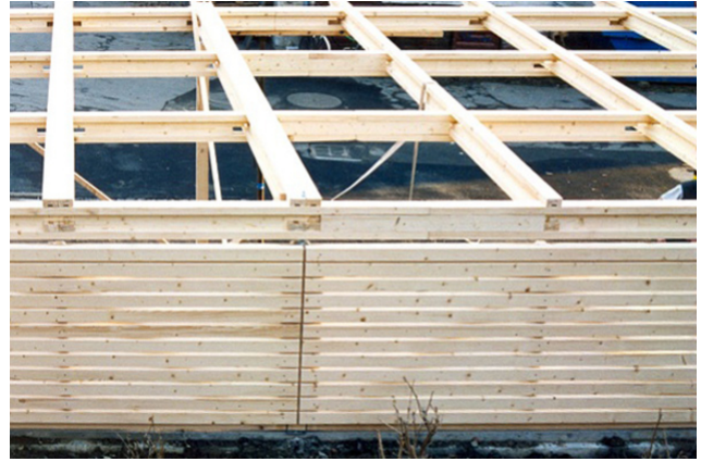
Abri pour voitures terminé
