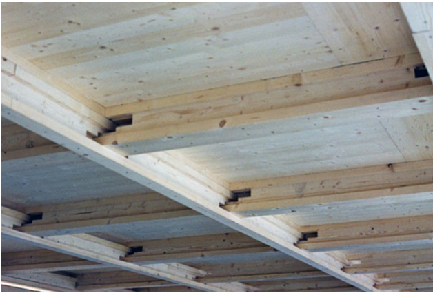
Grille de support terminée
