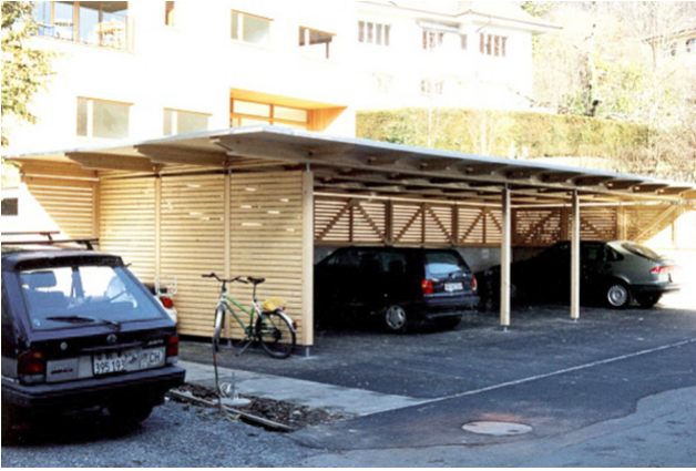
Abri pour voitures terminé
