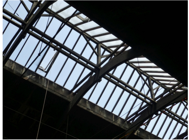
Vue intérieure du toit
