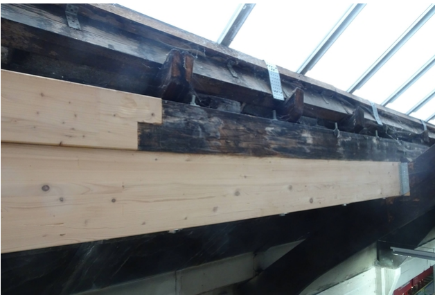
Remplacement des pannes chevron
