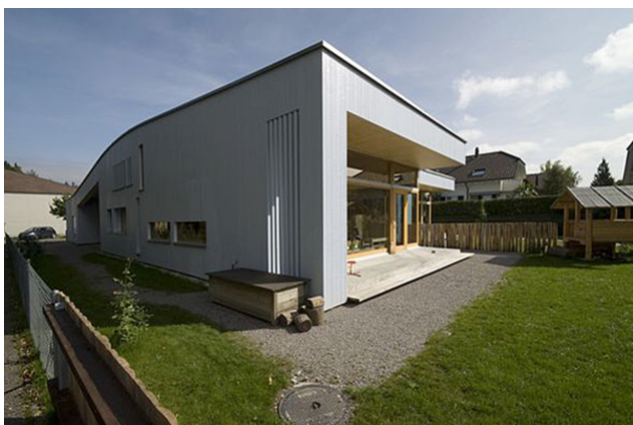
Vue extérieure côté entrée
