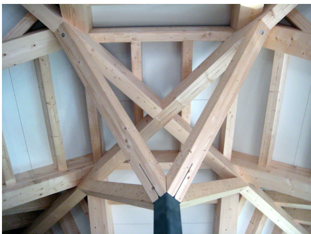
Construction du toit 2
