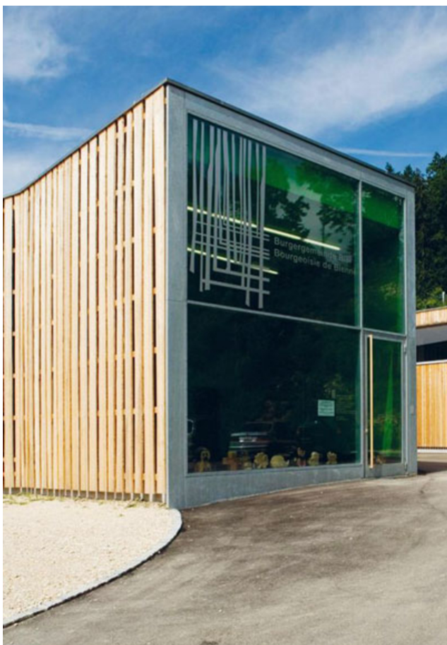
Vue détaillée de l'entrée
