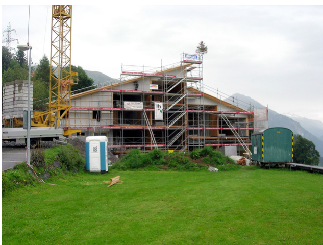
Gros œuvre du bâtiment
