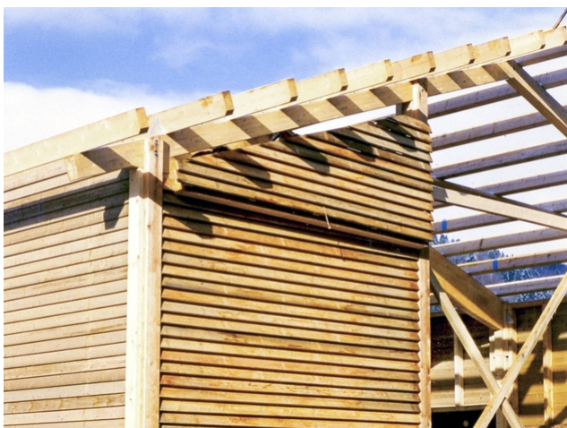
Montage des éléments muraux
