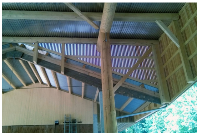
Structure porteuse dans le bâtiment fini
