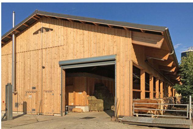
Vue rapprochée de la façade du magasin d'alimentation
