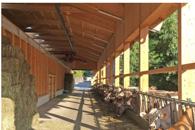
Vue intérieure de l'entrepôt de fourrage
