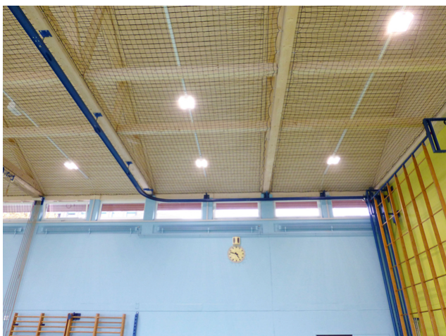
Vue intérieure du plafond
