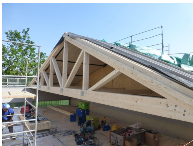
Galerie de toit
