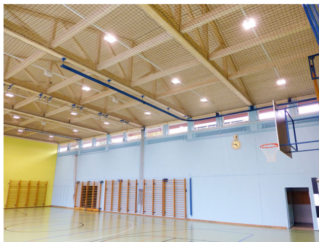
Vue intérieure du hall
