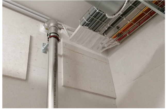
Cloisonnement du local technique
