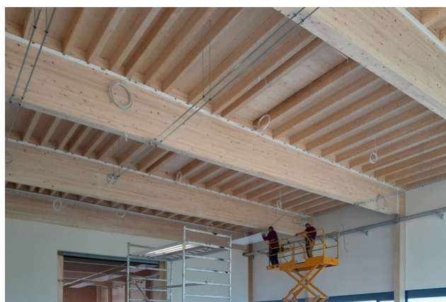
Construction du plafond de la salle
