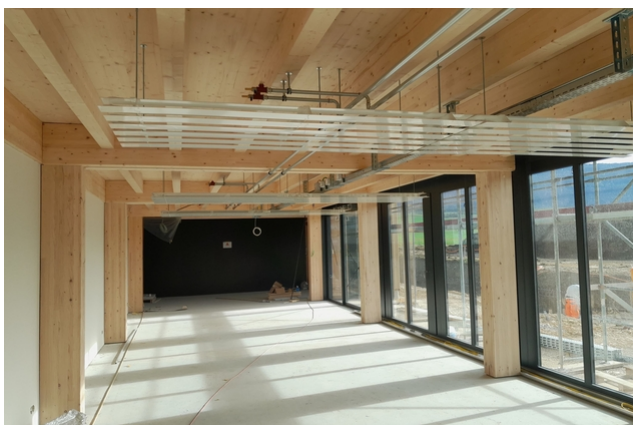
Vue intérieure de la partie bureaux
