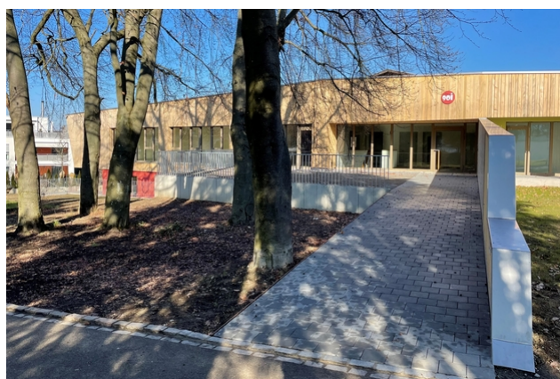
La construction et la façade sont en bois
