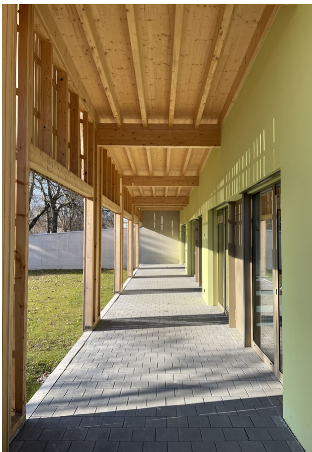
L'arcade avec les poutres apparentes
