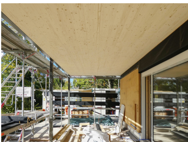
Une des terrasses en bois pendant les travaux de construction
