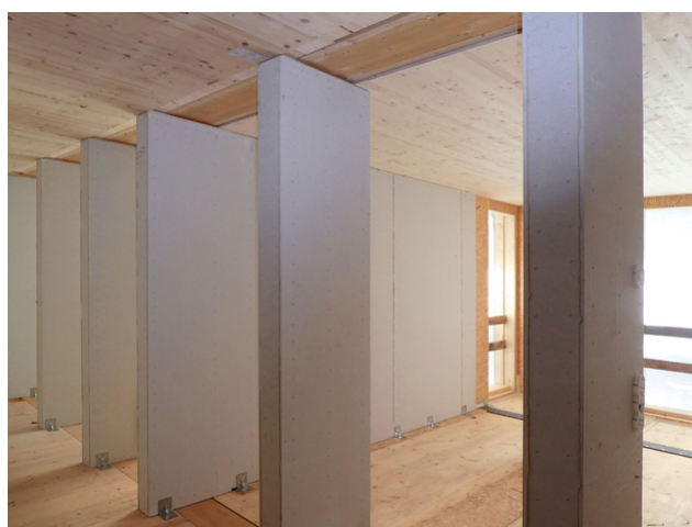
Vue de l'intérieur : Au premier plan, on peut voir les piliers qui soutiennent le plafond.
