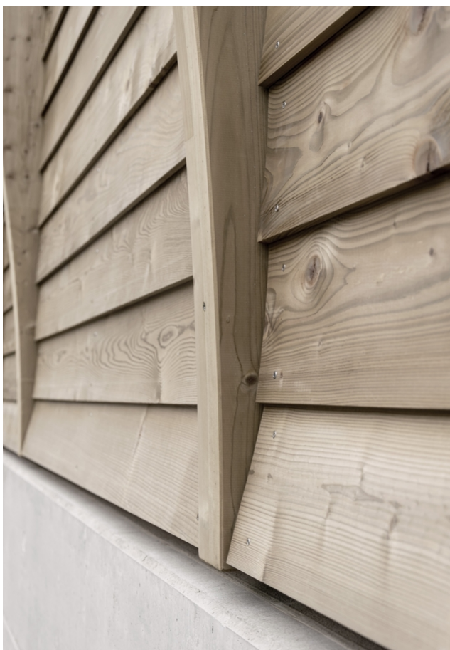
Détail du bardage de la façade
