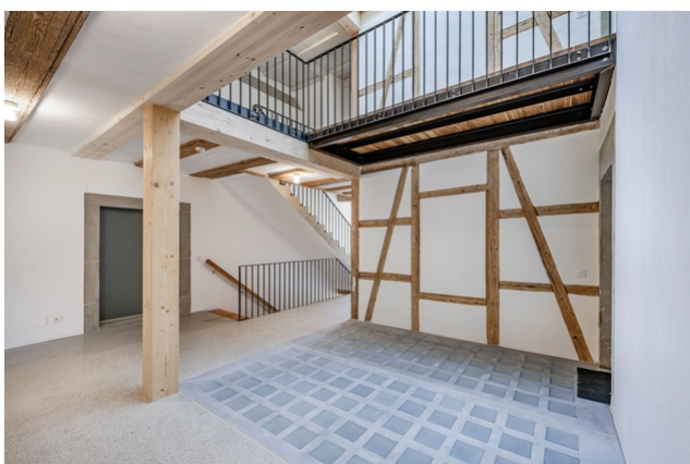
Combinaison des éléments nouveaux et existants dans la partie centrale
