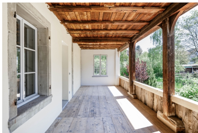
Pergola sur le côté sud du bâtiment
