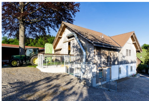
Vue extérieure de la grange rénovée.
