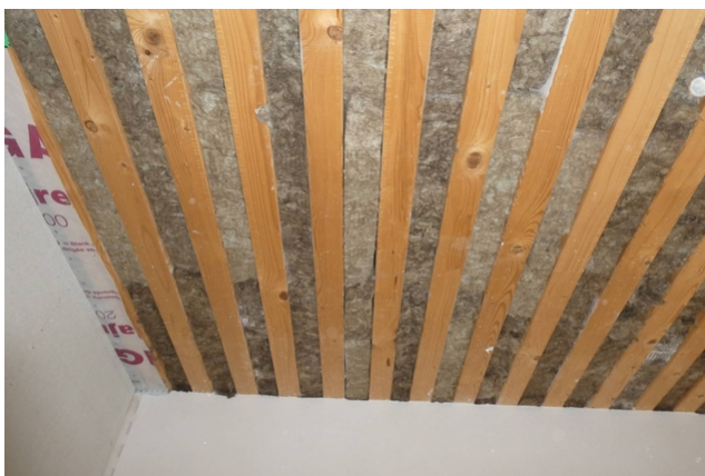
Isolation du plafond dans la rénovation de la grange.
