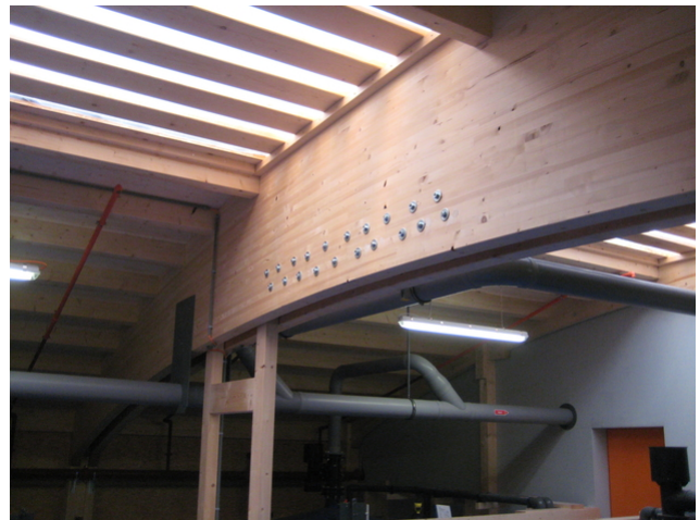
Assemblage de coques de toit
