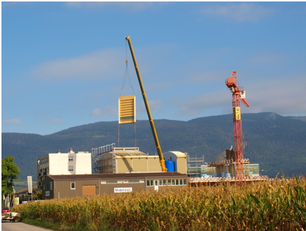
Montage des murs extérieurs
