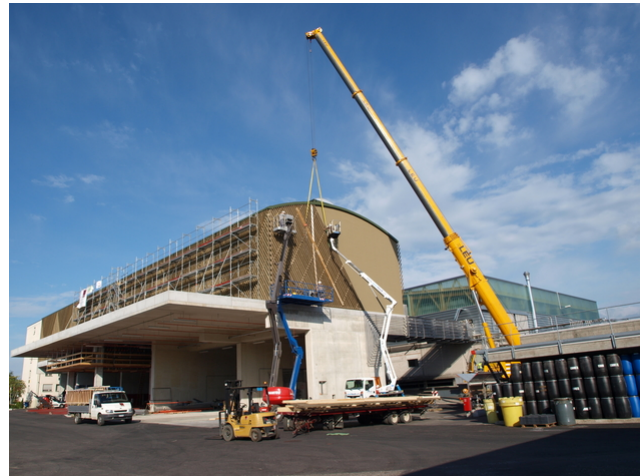
Montage des éléments de façade
