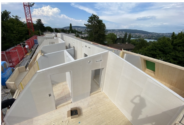
Vue directement dans l'élément de construction Surélévation
