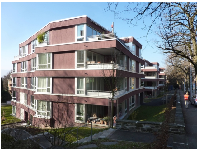
Vue extérieure de la 1ère étape
