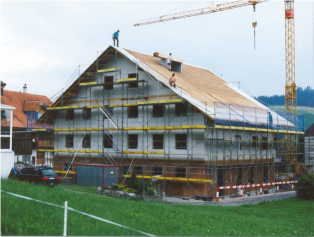
Pendant la phase de construction
