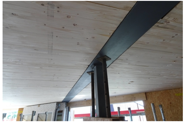
Poutrelle en acier intégrée au plafond
