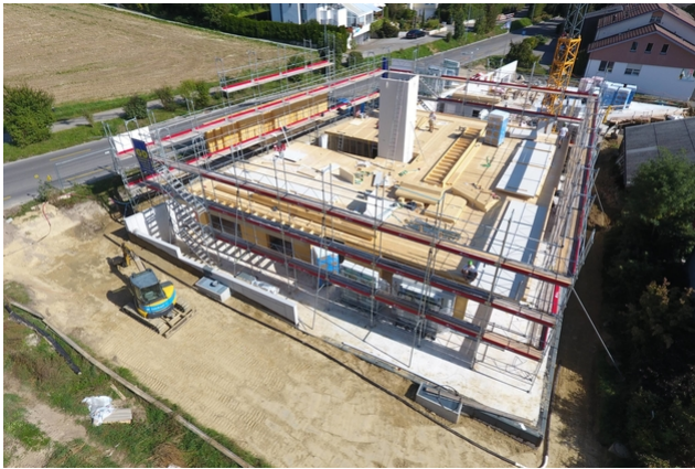
Cage d'ascenseur en CLT
