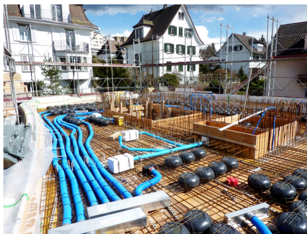
Dalle en béton au-dessus du rez-de-chaussée juste avant le bétonnage
