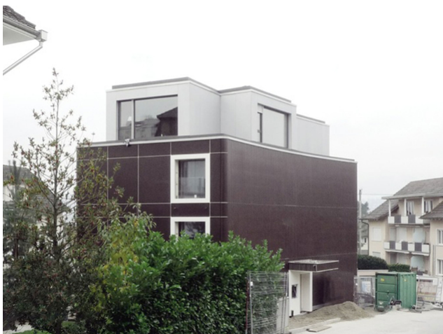
Vue extérieure d'en haut, côté rue
