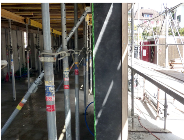
Parois porteuses en bois CE avant le bétonnage de la dalle CE
