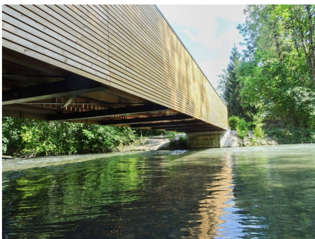
Espace suffisant entre la surface de l'eau et le pont
