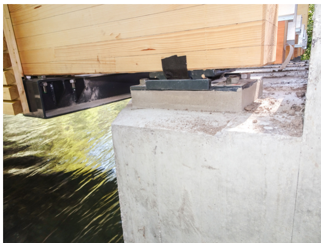
Le nouveau bridge a été monté sur les piliers existants
