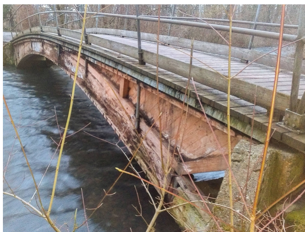
Il était urgent de remplacer l'ancienne passerelle.
