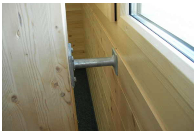
Détail soutien - façade
