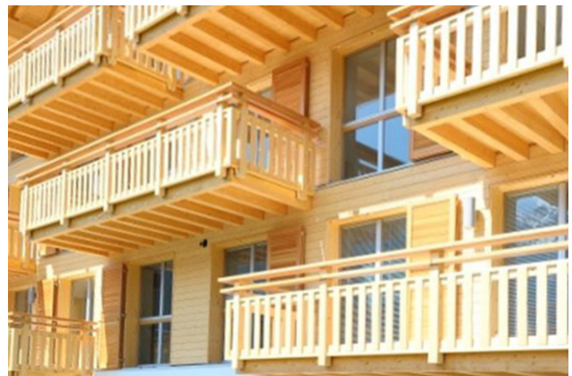
Façade avec balcons, photo Wenger Fenster Wimmis
