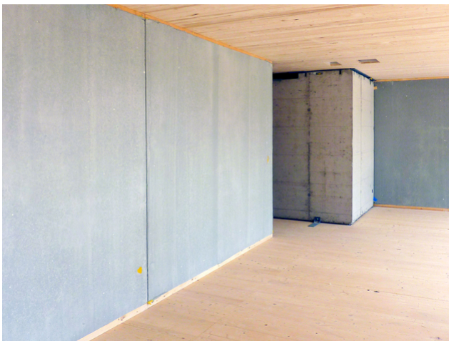
Vue du mur bois-béton
