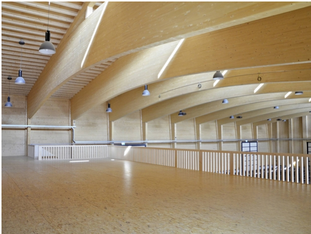
La galerie de la Simmental Arena : vue sur les arcs de liaison
