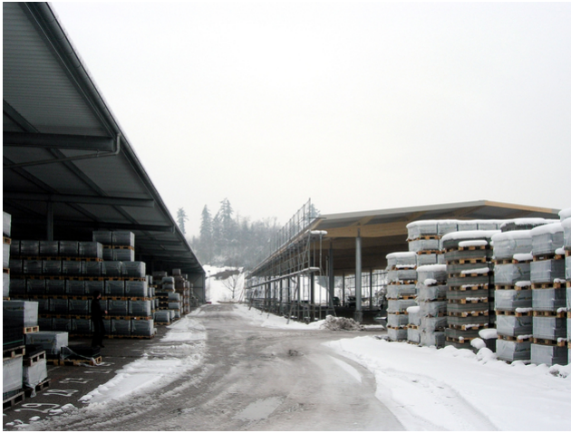
Ancien et nouveau toit
