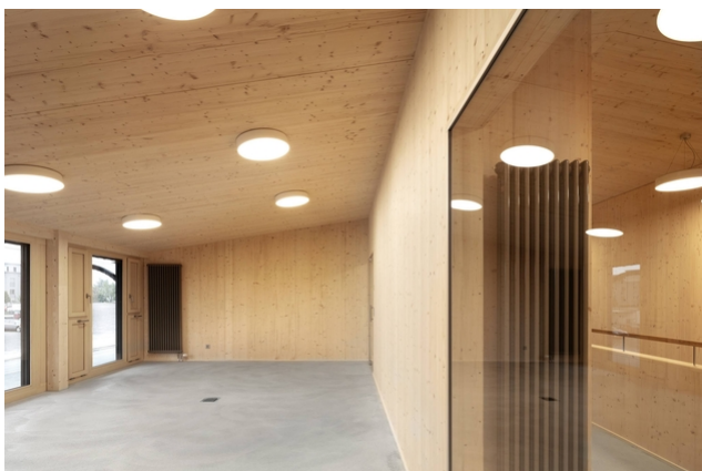
Surfaces en bois visibles à l'intérieur du Werkhof
