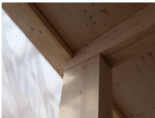
Appui Poutre sur support
