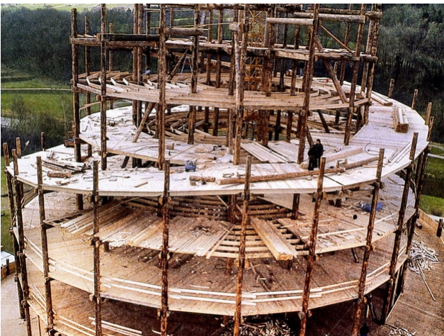
Tour en cours de construction
