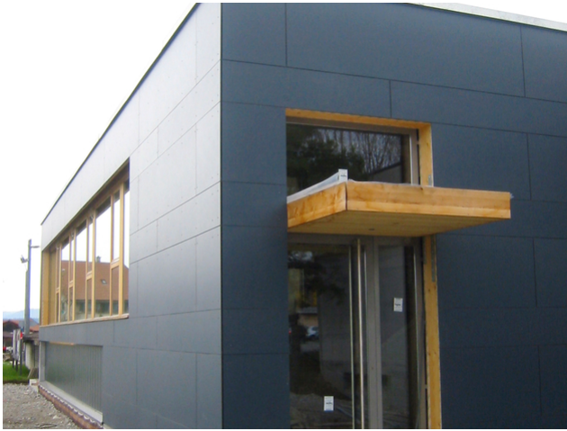
Entrée de l'immeuble de bureaux
