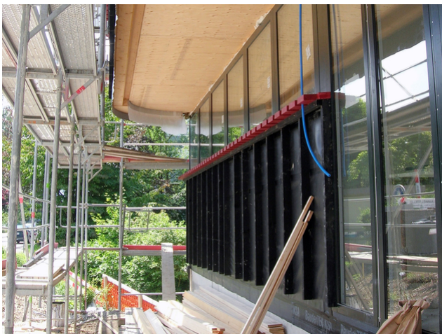
Plafond d'étage en porte-à-faux au niveau de l'accès
