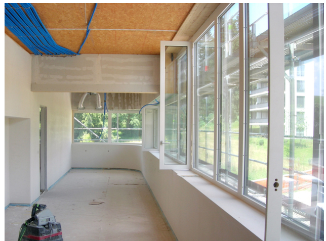
Niche de travail avec poutre BSH en saillie
