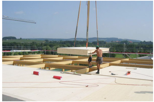
Montage d'éléments de toiture
