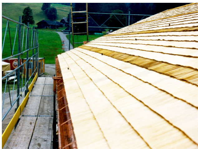
Travaux de bardeaux
