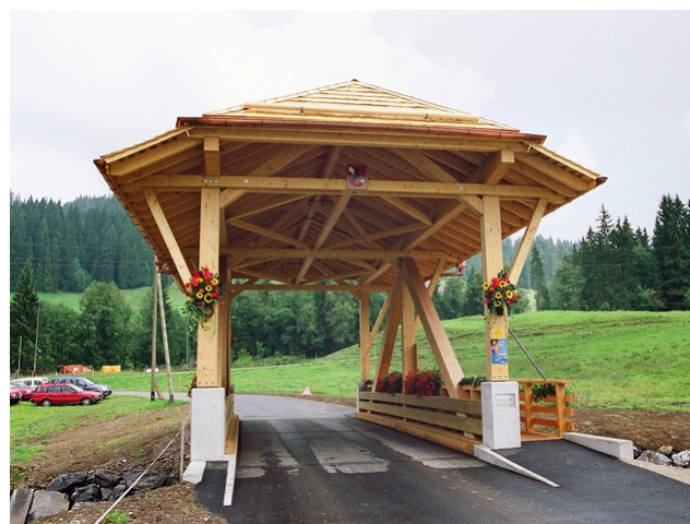
Vue sur le pont
