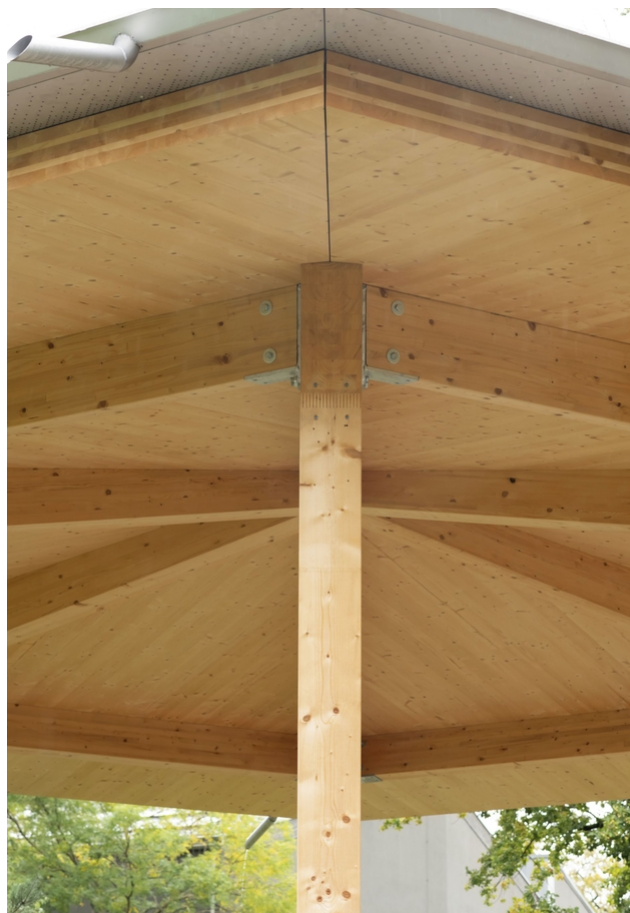
Vue sur les poteaux d'angle, raccords de poutres compris
