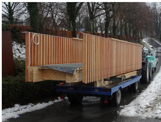
La structure de plusieurs tonnes a été livrée prête à rouler par un semi-remorque.
