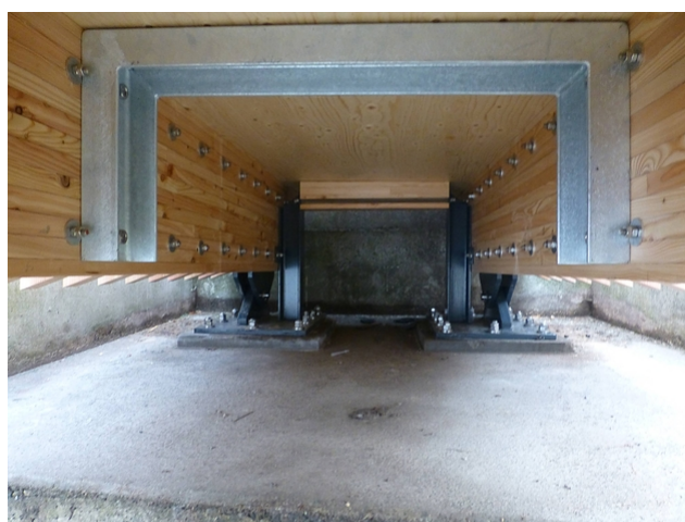
Le nouveau pont a été coincé dans la niche de pilier existante
