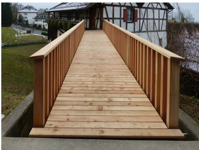
Le pont en bois offre un accès direct aux salles du musée
