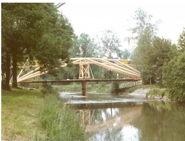
La nouvelle construction
