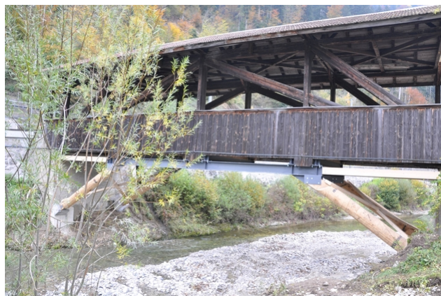
Vue du pont après la rénovation
