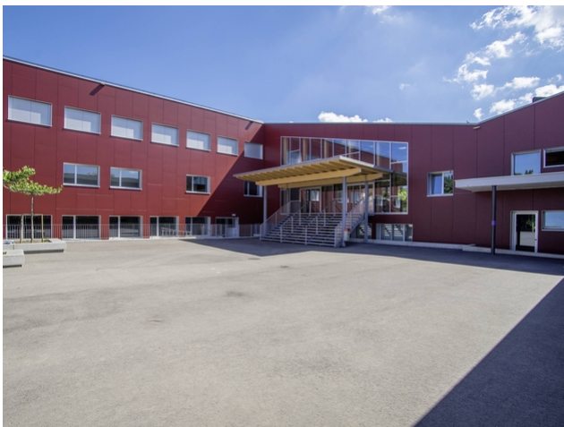
Une unité : à gauche, on voit le gymnase, à côté l'aile de liaison, à droite le bâtiment scolaire rénové
