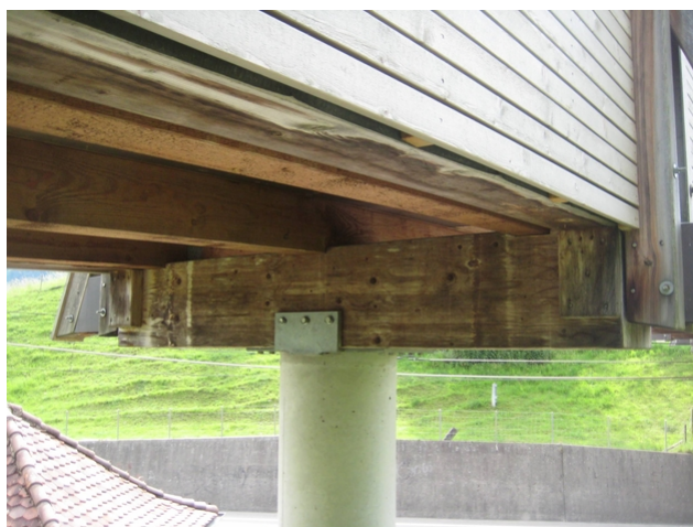
Détail de l'appui
