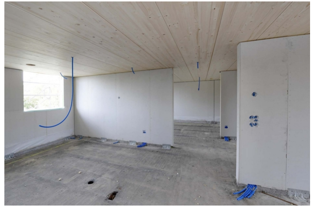
Vue intérieure sur le chantier avec le plafond de l'étage en bois
