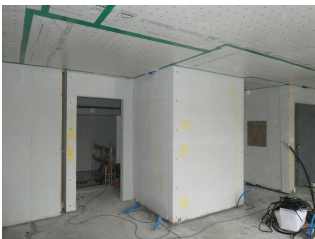
Cage d'escalier encapsulée en cours de construction
