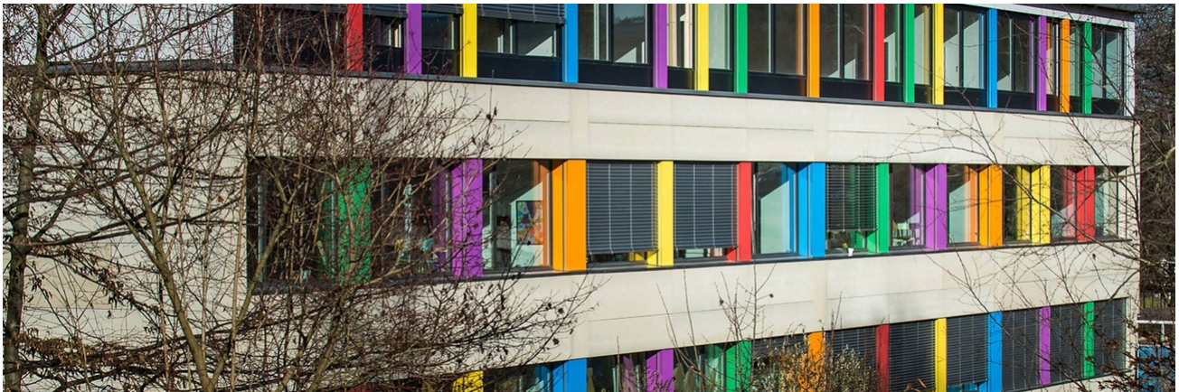
Le bâtiment scolaire datant des années 1950 a été surélevé d'un étage. Grâce au bois : les élèves ont désormais nettement plus de place
