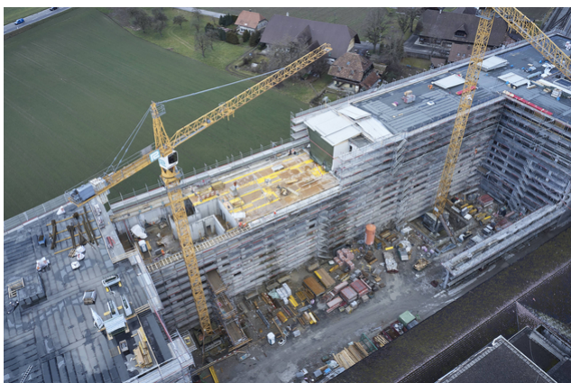
Vue aérienne pendant le redressement
