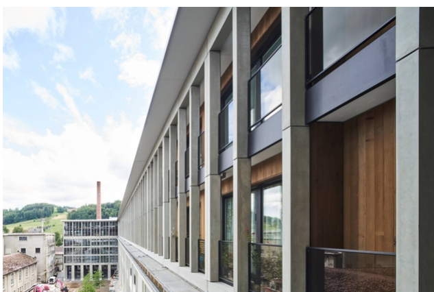
Vue du balcon
