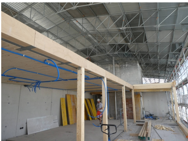
Surélévation sous le toit de secours
